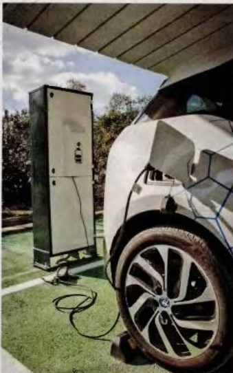
Ο σταθμός στο ΑΕΙ Πειραιά έχει τη δυνατότητα είτε να φορτίζει επί τόπου το όχημα είτε να αποθηκεύει την ενέργεια σε μπαταρίες. Έτσι, το ηλεκτρικό αυτοκίνητο μπορεί να εφοδιαστεί ενεργειακά οποιαδήποτε ώρα του 24ώρου.
