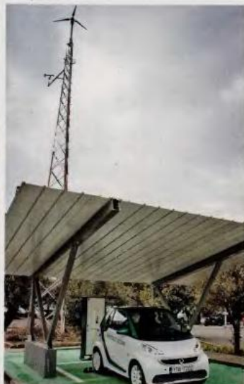
Ο σταθμός στο ΑΕΙ Πειραιά έχει τη δυνατότητα είτε να φορτίζει επί τόπου το όχημα είτε να αποθηκεύει την ενέργεια σε μπαταρίες. Έτσι, το ηλεκτρικό αυτοκίνητο μπορεί να εφοδιαστεί ενεργειακά οποιαδήποτε ώρα του 24ώρου.
